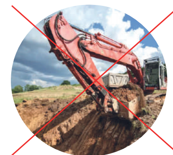
Terrassement et déblais
